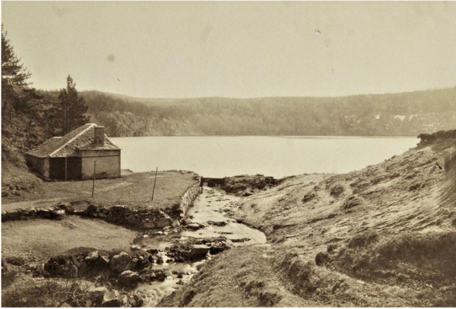
Fig. 3. L'entrée nord du cirque du lac Pavin, vers 1870–1880. À gauche : la maison du pêcheur construite vers 1859–1860. Au centre : le déversoir ; à droite : extrémité est du talus occidental (Photo Sanitas, coll. P. Chatelus).
